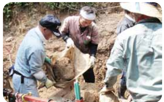
ボランティアによる土砂の撤去作業（八女市）
